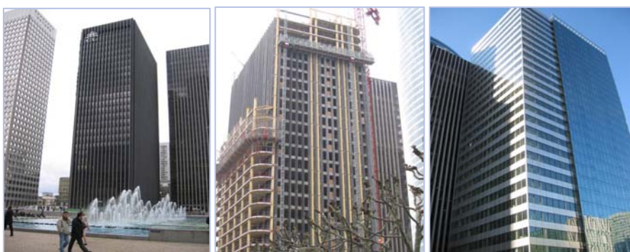
La Tour PB12 avant (à gauche), pendant (au milieu) et après (à droite) sa réhabilitation. La difficulté tenait à la hauteur du bâtiment, aux délais très serrés, à la nécessité de créer des structures porteuses plus résistantes et moins encombrantes que les poteaux initiaux en béton : un marché en or pour l'acier.
