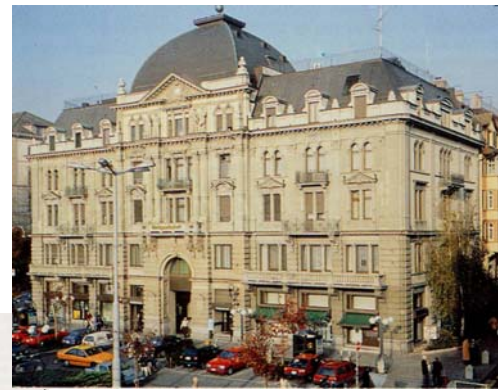
Derrière l'ancienne façade du « Roemerhof » de Zürich (ci-dessus et ci-contre), construit à la fin du 19 ème siècle, l'intérieur a été complètement vidé et remplacé par une ossature en acier avec dalles de plancher en béton. La réhabilitation a consisté à créer une stabilité interne, renforcer les fondations, démolir les planchers existants et enfin reconfigurer les volumes intérieurs.
