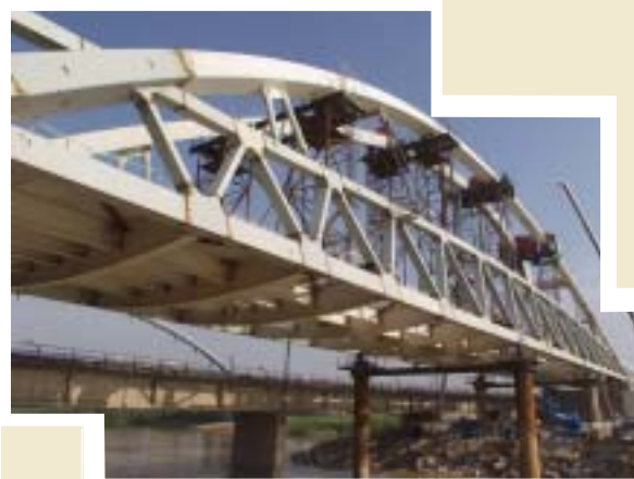
Ce pont en arc métallique de très grande portée, en construction à Saragosse, illustre la progression de l'acier dans les ponts TGV en Espagne.
