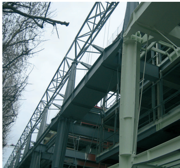
Centre de traitement et de valorisation de déchets Isséane à Issy-les-Moulineaux : les bureaux ont une structure en acier (Dubosc et Landowski Architectes).
