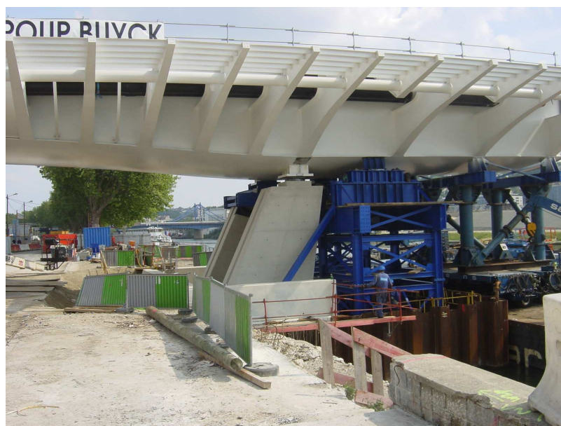
Photo 2 : Variation des larges encorbellements
