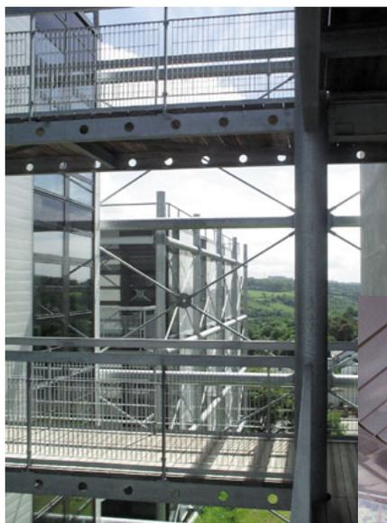
Outre ses propriétés de résistance à la corrosion, l'acier galvanisé nu est aussi utilisé pour son bel aspect. Ici pour les structures et enveloppe d'une pépinière d'entreprises à Cherbourg (à gauche) et d'un centre d'entretien d'autoroute (ci-dessous).
