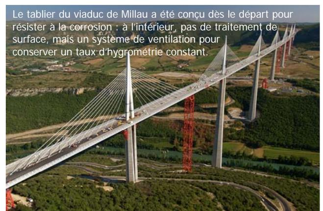
Le tablier du viaduc de Millau a été conçu dès le départ pour résister à la corrosion : à l'intérieur, pas de traitement de surface, mais un système de ventilation pour conserver un taux d'hygrométrie constant.
