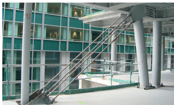
Immeuble Praetorium à La Défense : un bâtiment de bureaux de 8 étages avec poutrelles alvéolaires et planchers collaborants en acier (Arte Charpentier & associés, architectes).
