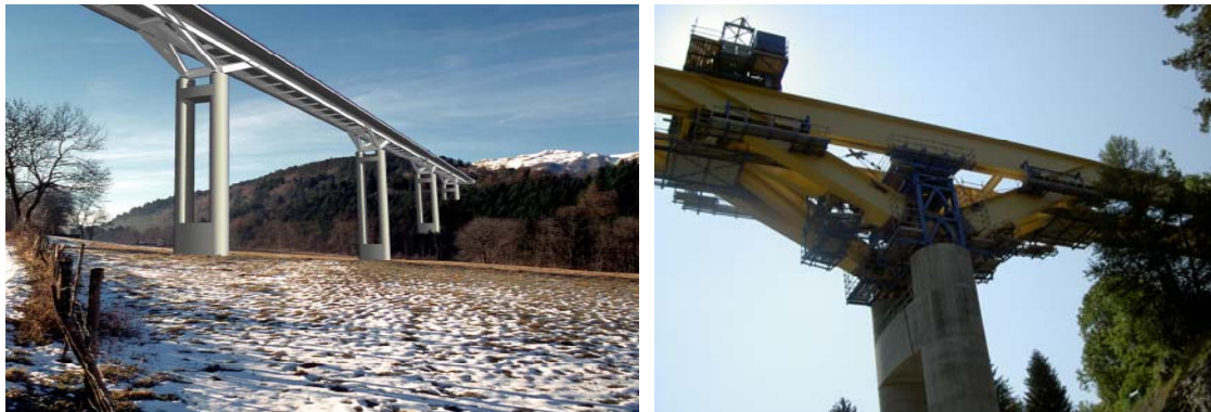
Figure 3 : Viaduc de Monestier de Clermont Un tablier mince et aérien (structure bipoutre en acier) grâce à la mise en place de bracons
