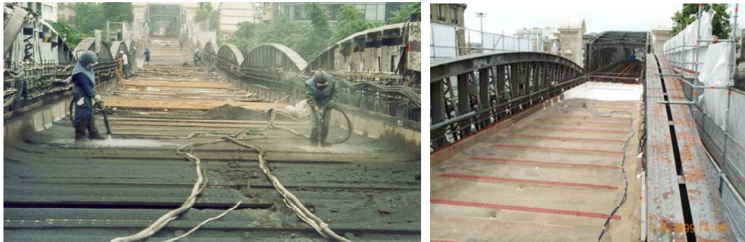
Figure 10 : La rénovation de la ligne RATP n°6 a révélé une structure en état de conservation remarquable, bien que construite au début du XX ème siècle
