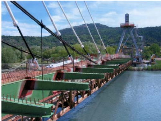
Figure 13 : Pont haubané de Volonne (Alpes de Haute Provence)
