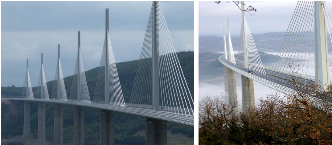
Figure 13 : Viaduc de Millau - Durée de vie initiale prévue à la conception : 120 ans (compte non tenu d'un allongement possible grâce à l'entretien, la maintenance et d'éventuelles réhabilitations)
