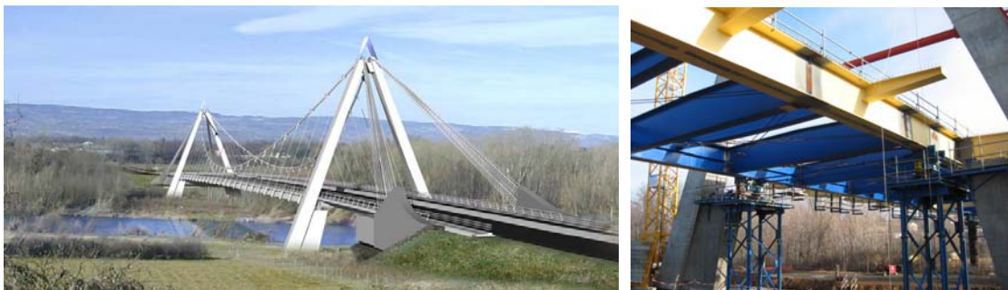
Figure 4 : Grand Pont sur la Loire à Andrézieux - Bouthéon (Saint Etienne)
