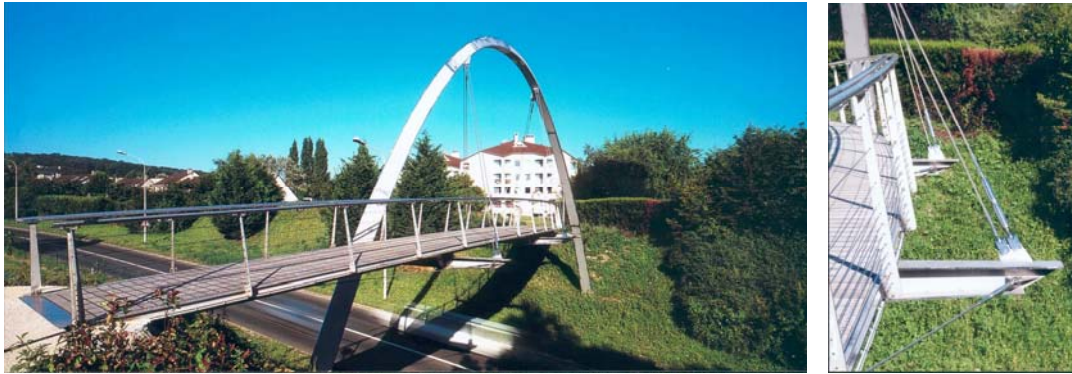
Figure 5 : Passerelle des Charveaux à Andrésy (Yvelines)
