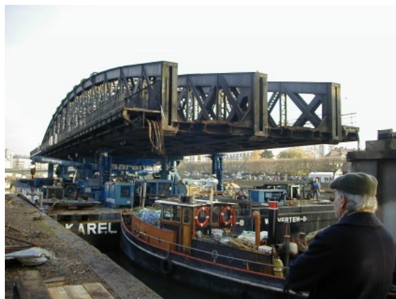
Figure 15 : Démontage du pont ferroviaire de Pontoise (1861 – 1999)
