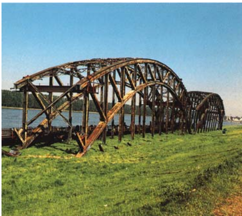
Figure 14 : Démontage du pont de Hammer à Düsseldorf
