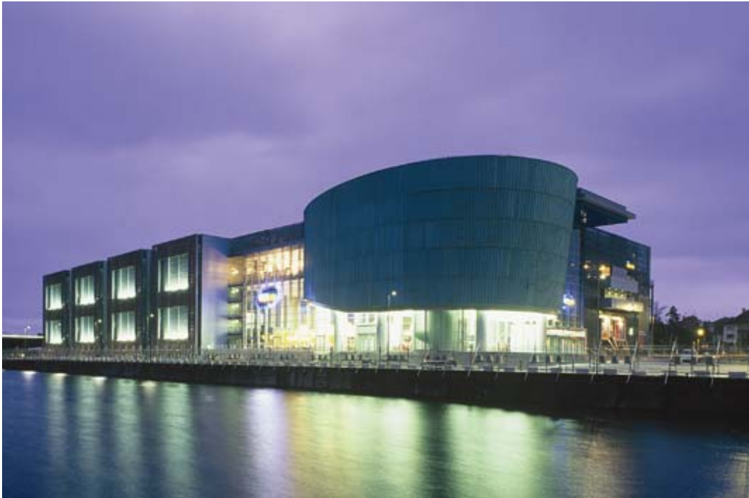
Figure 9 : UGC Ciné-Cité Strasbourg, Strasbourg Les cloisons acoustiques sur ossature acier permettent d'atteindre des niveaux d'affaiblissement sonore très élevés (de l'ordre de 80 dB), indispensables pour assurer un isolement total entre salles de cinéma.
