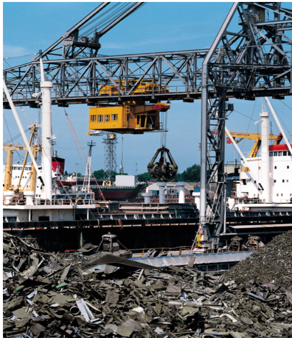
Figure 13 : Centre de tri et de recyclage de l'acier
