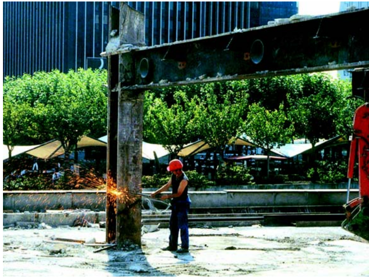
Figure 12 : Démontage de la Tour Esso à La Défense
