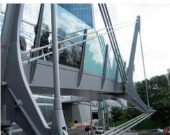
Passerelle Granite de La Défense (Feichtinger)
