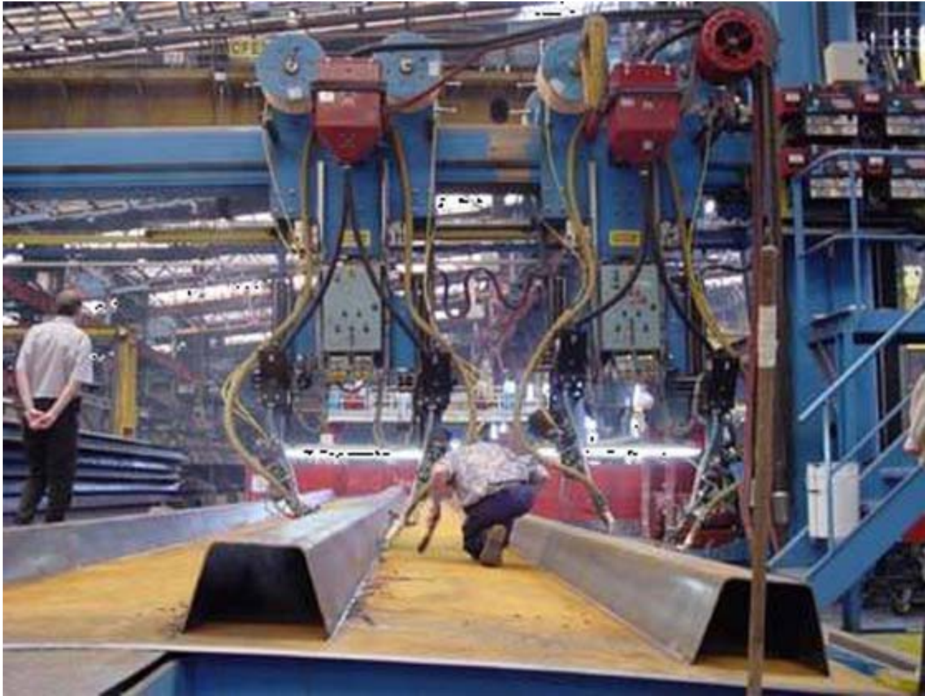
Préfabrication Viaduc de Millau - Atelier EFFEL à Lauterbourg -
